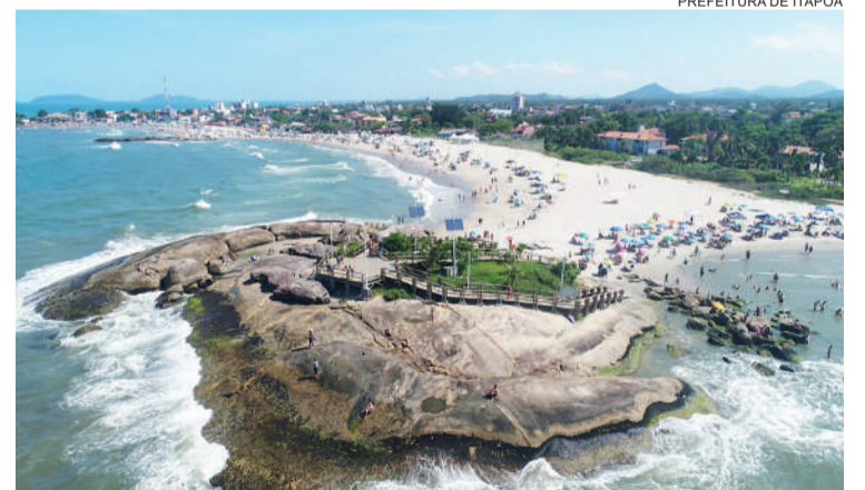
A obra de alargamento da praia de Itapoá se estenderá por 8 quilômetros
