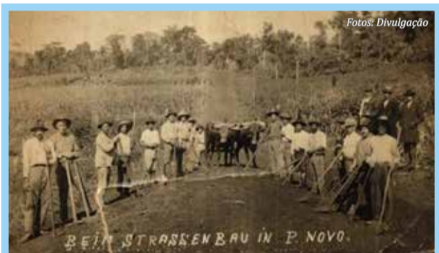
Construção pelos migrantes da estrada que liga Tunas a Porto Novo, hoje Itapiranga (Acervo do Museu Municipal Ida Schneider)
