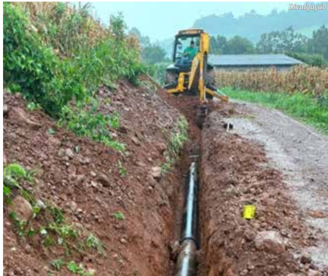
Instalação da adutora
