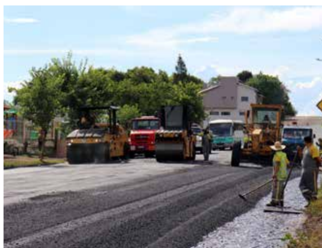
Obras estão em ritmo intenso
