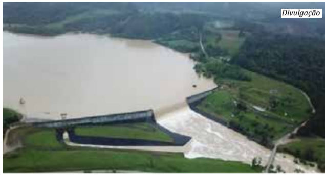
Barragem de Taió
