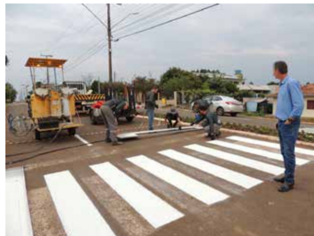
O Governo Municipal contratou 1.700 metros quadrados de pintura
