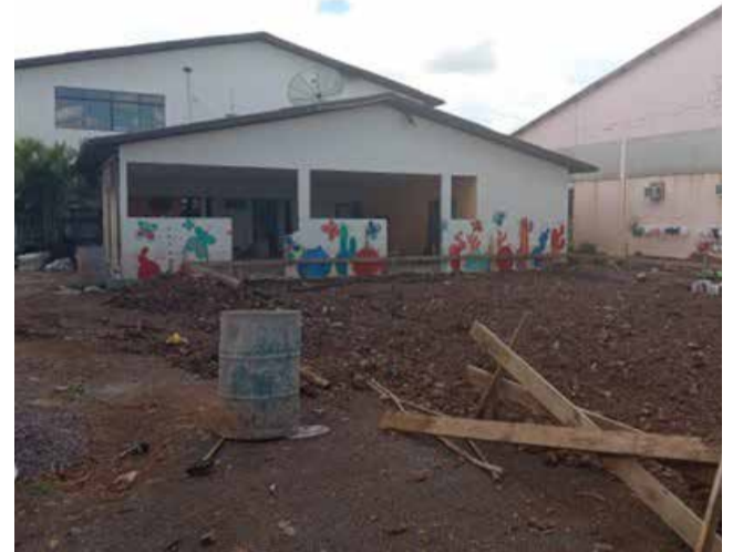
Obras da escola em andamento
