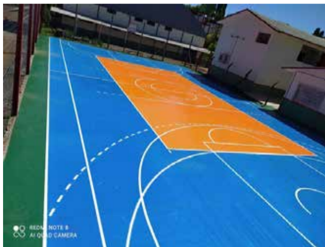
Resultado final da obra.
