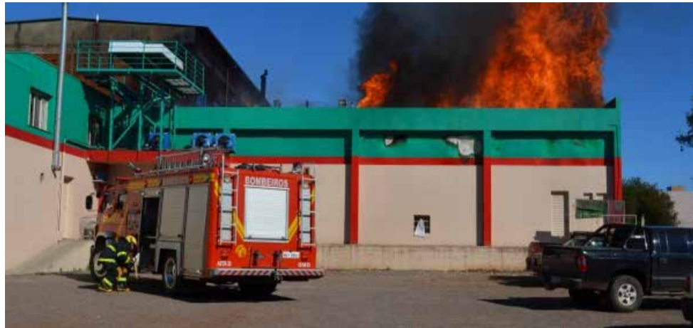
Incêndio destruiu totalmente a estrutura do supermercado na Rua Almirante Tamandaré
