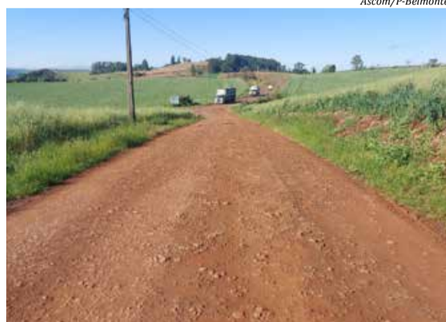
A vencedora terá cerca de R$ 181,4 mil para realizar o calçamento no trecho Sul do acesso a comunidade e no acesso ao Camping Decol
