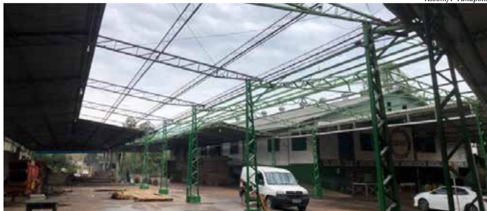
Pavilhões estão recebendo passando por reformas para melhorar a estrutura
