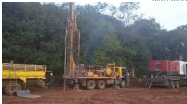
Com uma profundidade de cerca de 140 metros, o poço terá a vasão para atender moradores da Linha Tabajara e comunidades
