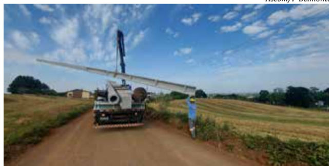
O trabalho prevê a colocação de postes, rede de energia e iluminação pública
