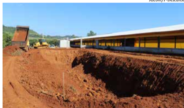
Durante o programa foram construídas 22 cisternas, que juntas, possuem capacidade de reservar cerca de 20 milhões de litros de água
