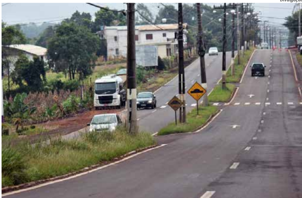
Principal acesso à cidade, Willy Barth deve ser completamente revitalizada
