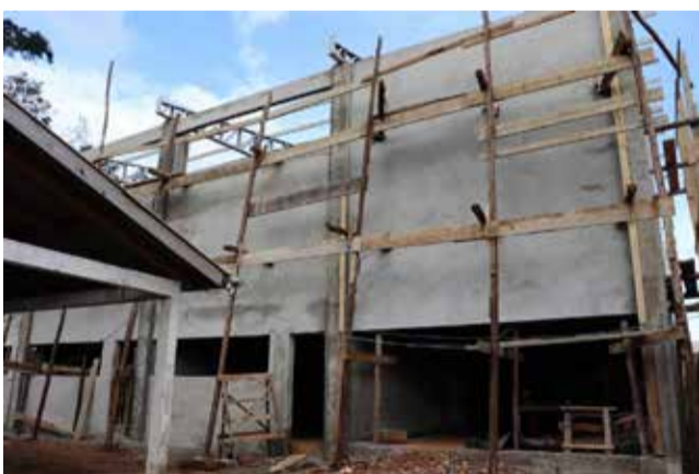
Obras do ginásio estão avançadas
