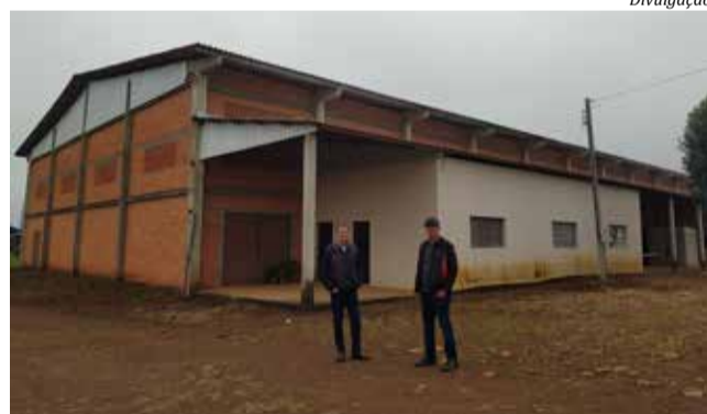
Estrutura deverá passar por reformas
