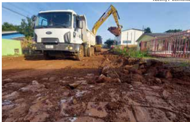
O trabalho atual visa corrigir alguns trechos onde a pista acabou sofrendo danos na base e drenagem
