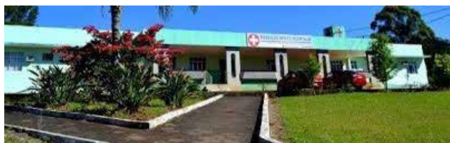
Hospital da Fundação Médica de Descanso
