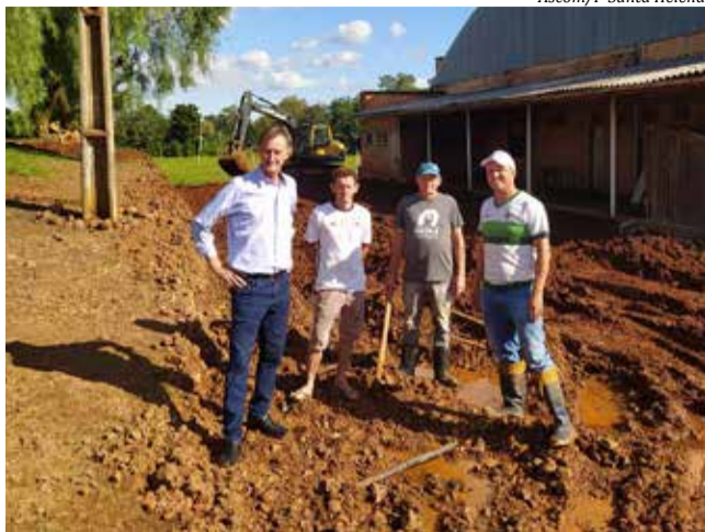
Prefeito Blásio Hickmann visitou as obras de melhoria
