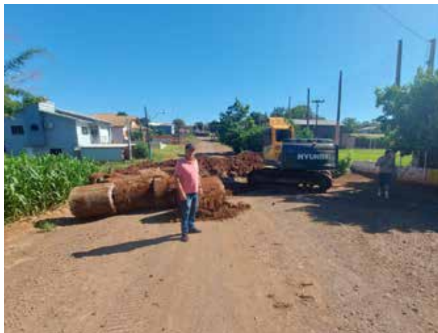
As ruas beneficiadas são a Nossa Senhora Jesus de Baitaca, rua Manuel Ribas e trecho da Padre Réus, no acesso Sul da cidade
