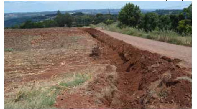
Obras estão sendo realizadas no interior do município
