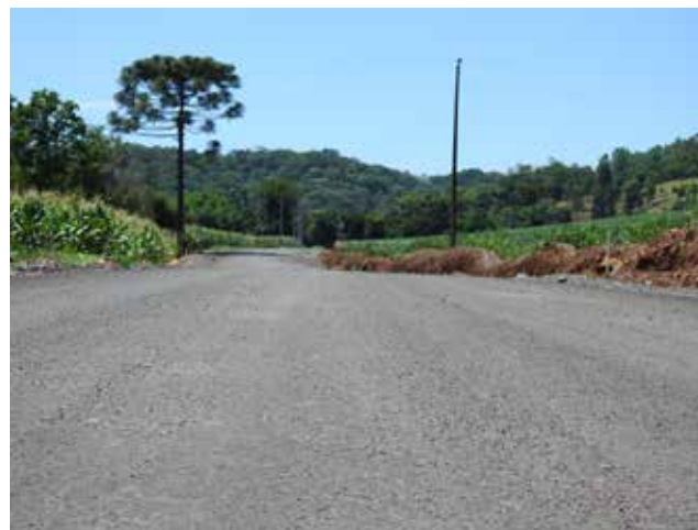
Asfaltamento à linha Fátima está em fase de conclusão
