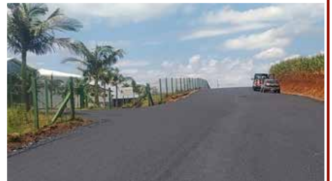
Obras de asfaltamento à linha Cruzinhas estão concluídas
