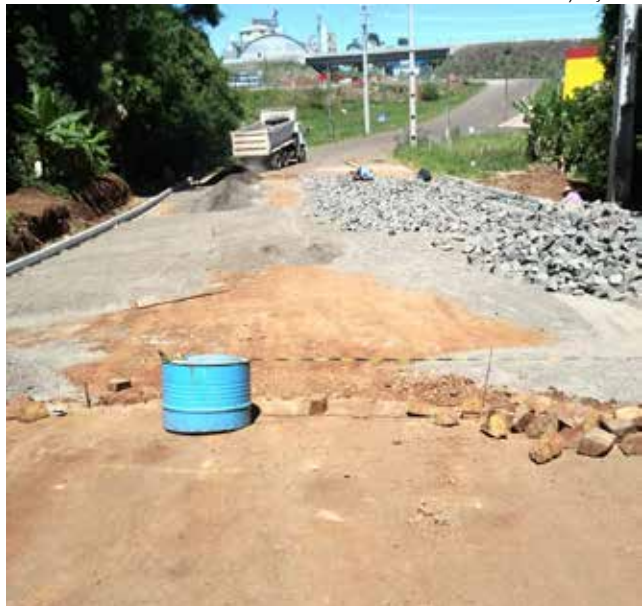
Obras iniciaram pela Rua Odilo Link
