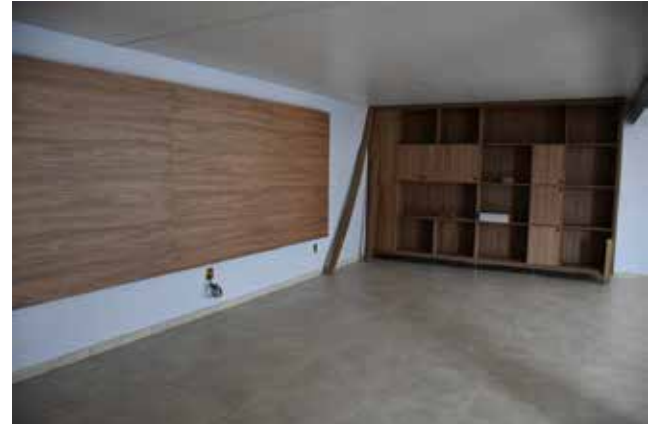
Estrutura está em fase final de instalação
