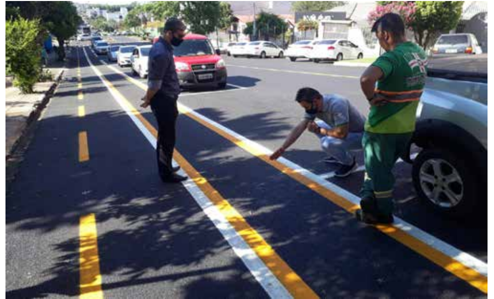
Antes de estender a ciclofaixa para a Rua Marcílio Dias, o município realizou a recuperação asfáltica total deste trecho
