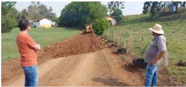
Prefeito Jair Giumbelli esteve na propriedade da família Scaranti, na comunidade de Bela União, onde equipes trabalham na execução de uma terraplanagem
