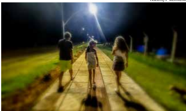
A prefeitura investiu cerca de R$ 16,8 mil para instalação de dois padrões de energia e a rede de alimentação
