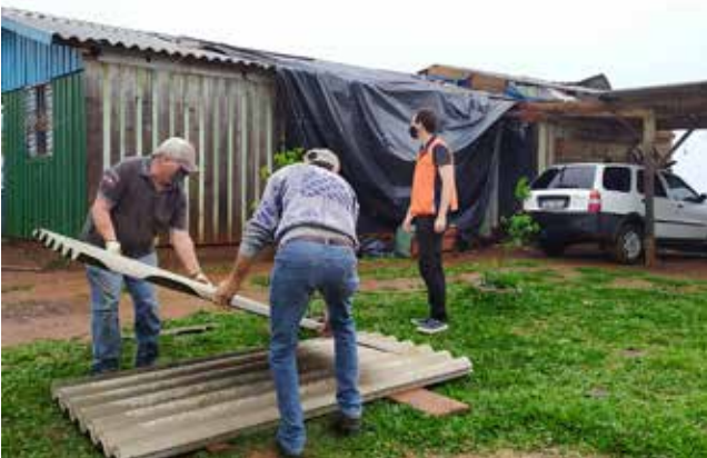
Poder público auxiliou os atingidos com lonas e telhas
