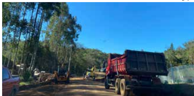
Obras estão sendo realizadas na comunidade de Linha Fátima
