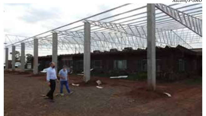
Prefeito Wilson Trevisan e o vice-prefeito e secretário de Desenvolvimento Sustentável, Edenilson Zanardi, vistoriaram os trabalhos
