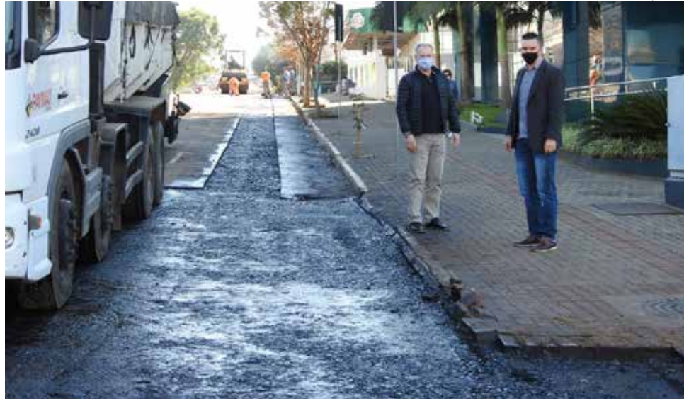
Prefeito Wilson Trevisan e o diretor de Trânsito, Cássio da Silva, estiveram verificando os serviços iniciais de adequação
