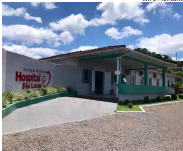
Repases servirão para instalação do grupo gerador de energia
