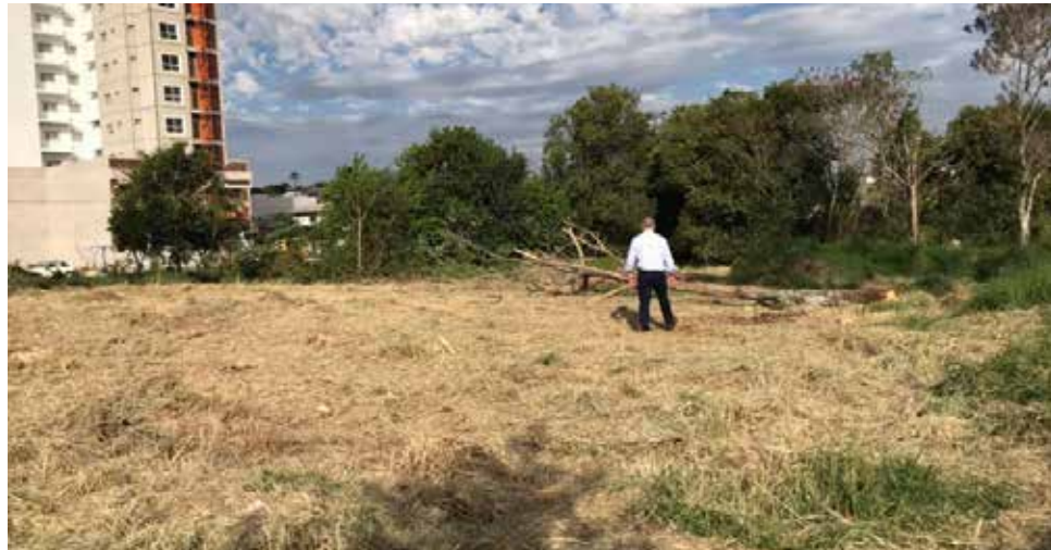
Prefeito Wilson Trevisan acompanhou o início das obras no local
