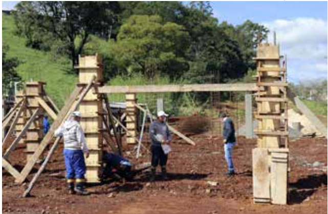
Prefeito Sadi Bonamigo acompanha o andamento das obras em execução
