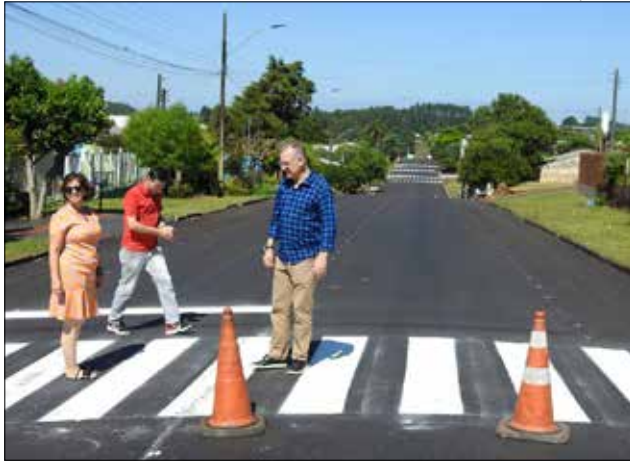
Prefeito e secretários percorreram bairros onde estão sendo feitas obras de asfaltamento
