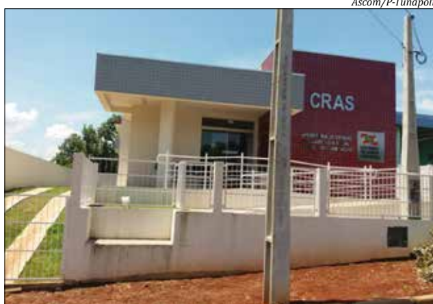
A nova estrutura está situada na rua Peperi, ao lado da antiga rodoviária
