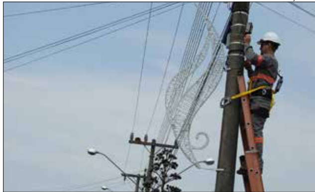
Decoração começou a ser instalada nas rótulas e Avenida Getúlio Vargas
