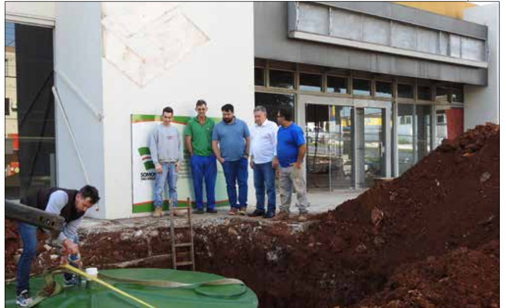
Obras foram vistoriadas pelas autoridades na semana passada
