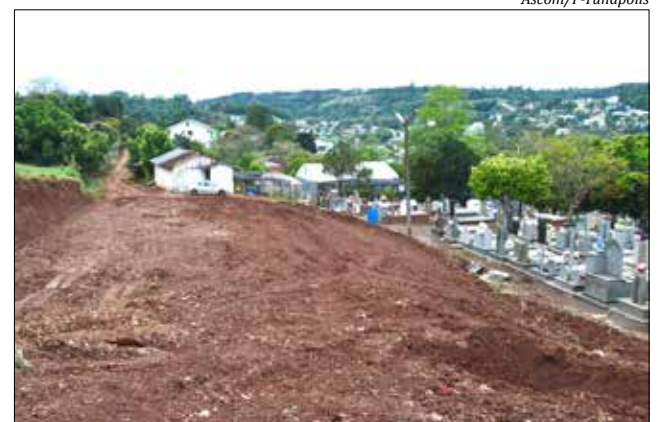
Parte superior do terreno vai abrigar um gaveteiro opções de enterro. "Esse espaço novo está sendo pensado para ser adequado, acolhedor para visitação e de respeito com os mortos", salienta.
