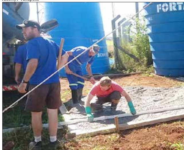
Bases estão sendo instaladas em vários pontos do interior
