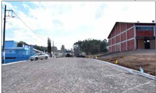
Pavimentação teve investimentos de quase R$ 290 mil em recursos próprios
