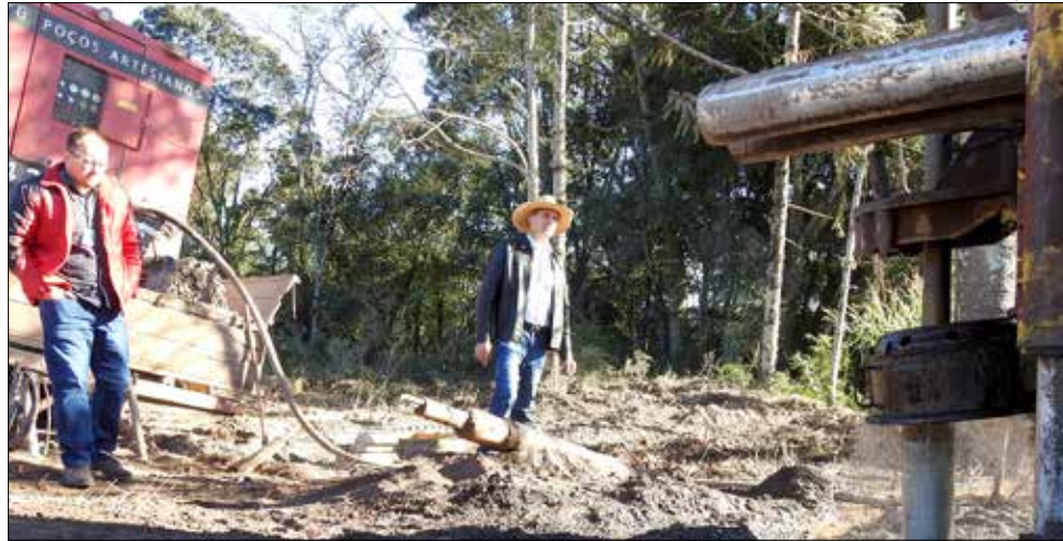
A perfuração do primeiro poço foi concluída na manhã de terça-feira, na Linha Jacutinga
