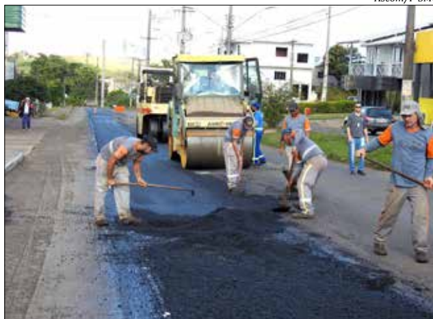
Obras estão sendo desenvolvidas na Willy Barth e várias outras ruas centrais
