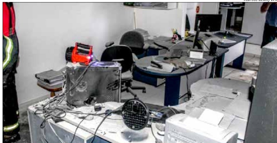
Fogo queimou documentos e danificou equipamentos
