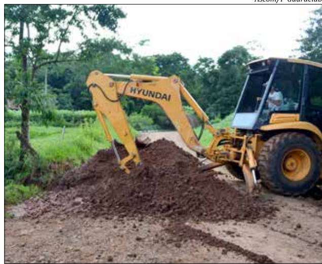
Máquinas trabalharam em recuperação de um bueiro em Linha Tigre
