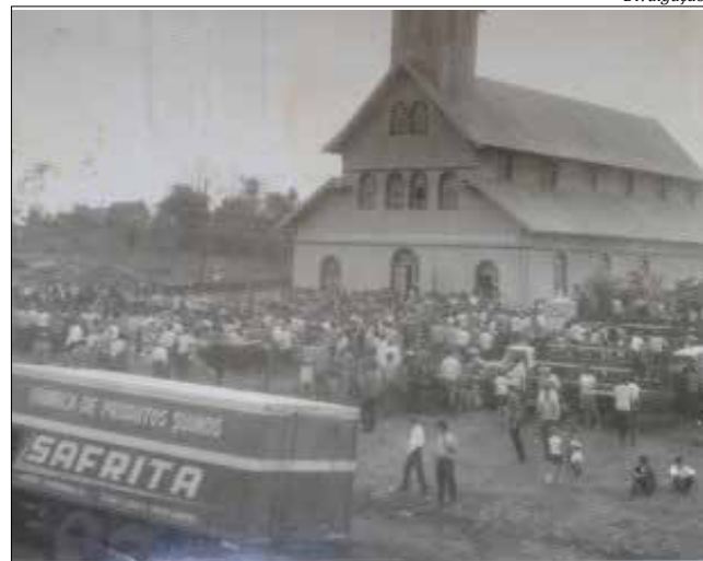
Ângulo do então distrito no início da década de 1960. No canto inferior, a câmara fria do frigorífico Safrita, atualmente JBS, instalado no município de Itapiranga
