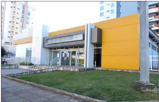
Estrutura do antigo Besc passar por adequações e receberá creche
