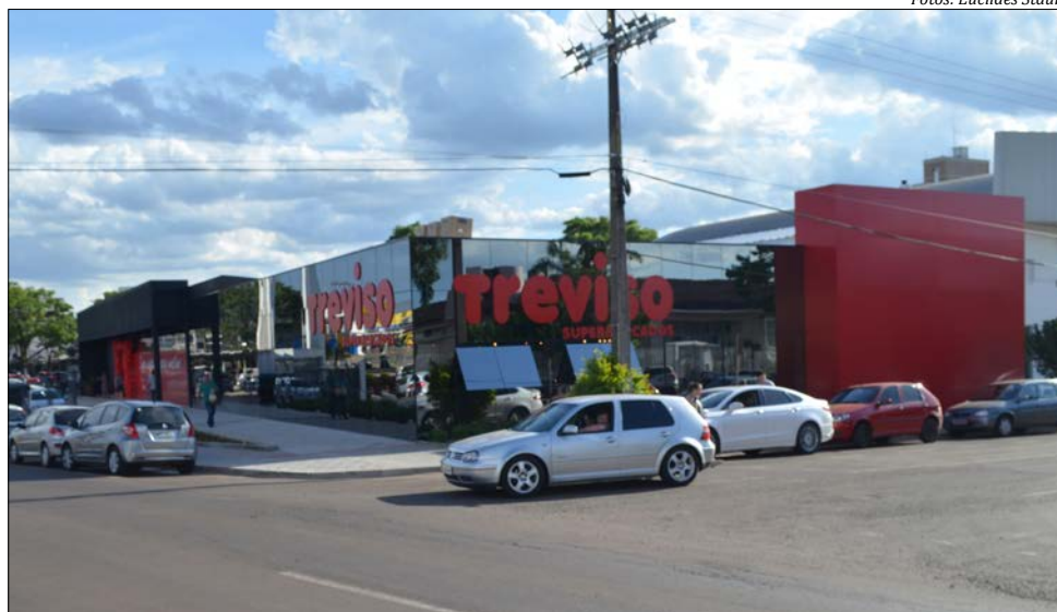
Nova loja está instalada na Rua Willy Barth, nas antigas instalações da Sapema
