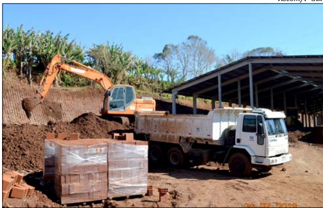
O trabalho é desenvolvido e em terraplanagens para construção de novos aviários e também granjas de suínos
