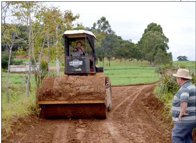
Máquinas realizam trabalhos de patrolamento e compactação
