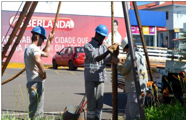
Sondagens no solo foi feita em 13 pontos do perímetro urbano do município
