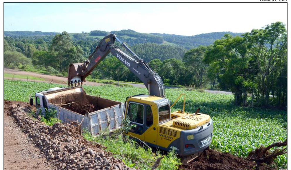
Máquinas trabalham no aterro para ampliação da empresa
