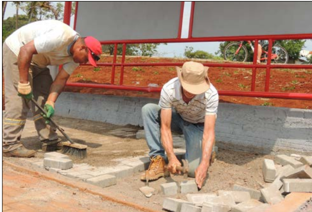
Equipe trabalha na recuperação de meio fio em canteiros centrais e laterais das vias públicas
