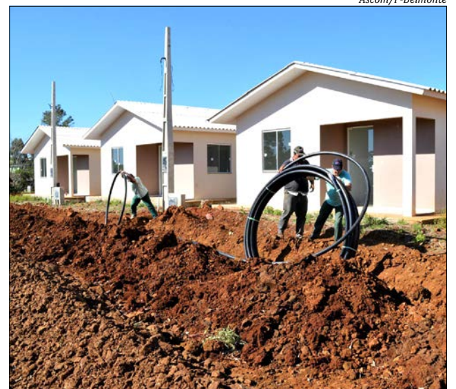
Nos próximos dias também deve acontecer a ligação da rede de energia elétrica
