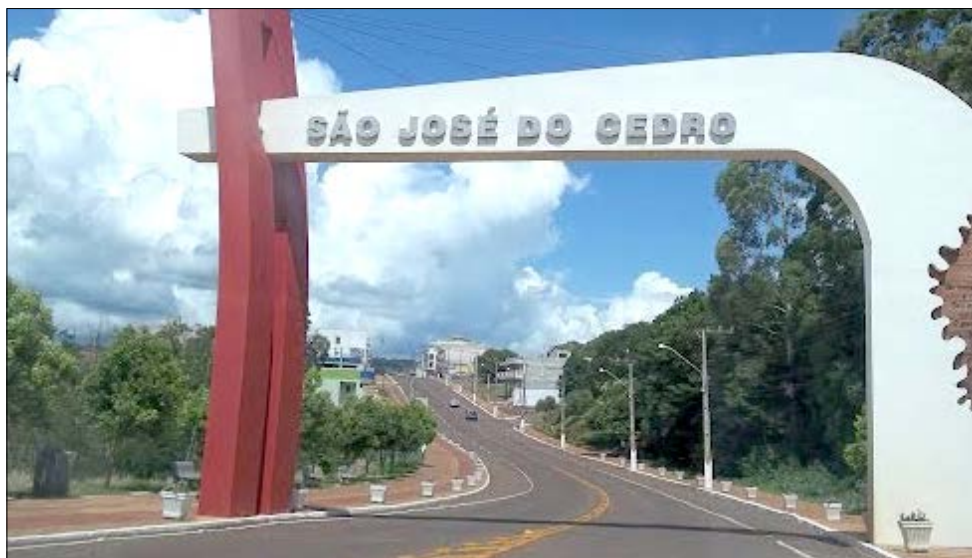
Portal de acesso a São José do Cedro, à margem da BR-163
