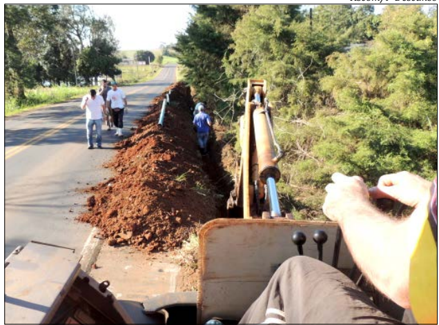
Valas começaram a ser abertas para a colocação da tubulação
