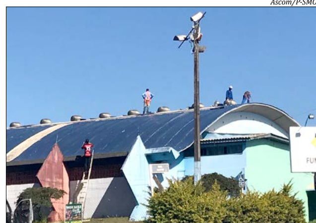
Obras foram feitas durante o último final de semana
